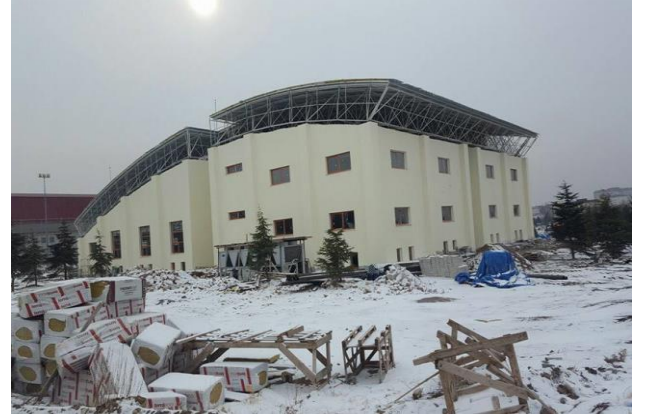
Antreman Sahalari Binası
